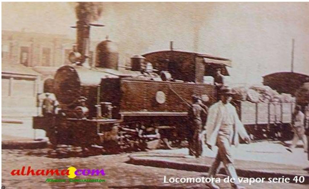
Estaba este grupo constituido por tres locomotoras numeradas de la 41 a la 43. Eran del tipo 030T mixtas de adherencia y cremallera ya que estaban destinadas a la línea de Ventas de Zafarraya. Fueron construidas por SLM, las dos primeras en 1920 con números de fábrica 2759-60 y la tercera en 1924, con número 2942. Estas locomotoras eran prácticamente idénticas a la serie 1051 a 1068 del ferrocarril de Brunig (Suiza).
