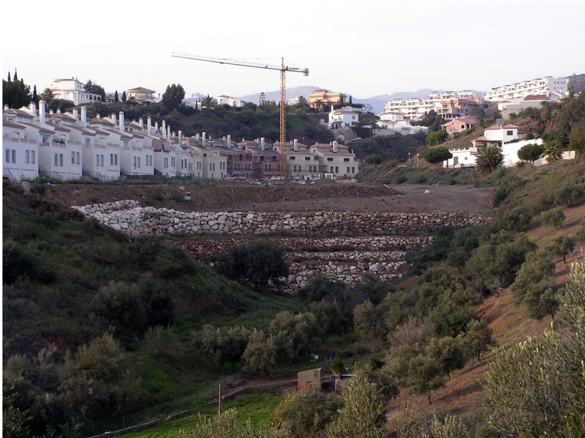
Urb Paraíso del Sol. Escollera de contención sobre el arroyo Serrezuela 01/01/2004.
